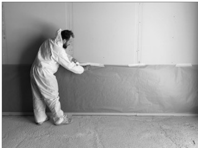
Figure 2 : Protection des éléments de construction
