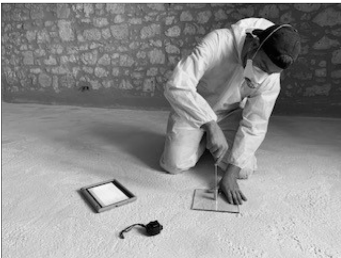
Figure 11 : Prise d'épaisseur et enregistrement sur iso'app
