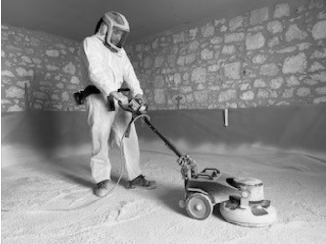
Figure 10 : Ponçage de la surface isolée
