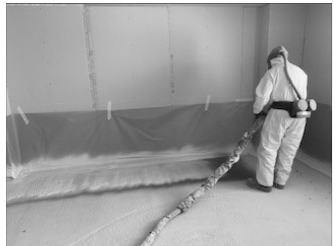
Figure 9 : Projection de l'isolant
