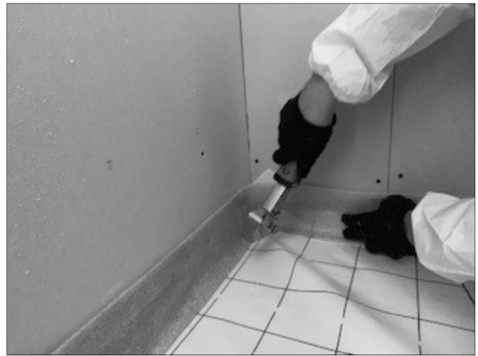
Figure 12 : Réalisation de la désolidarisation périphérique
